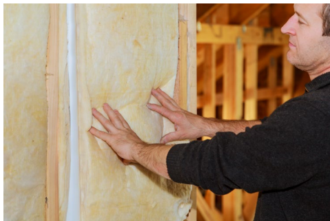
Lã de rocha / lã de vidro é irritante, liberta partículas e absorve a humidade, causando bolor e mofo
